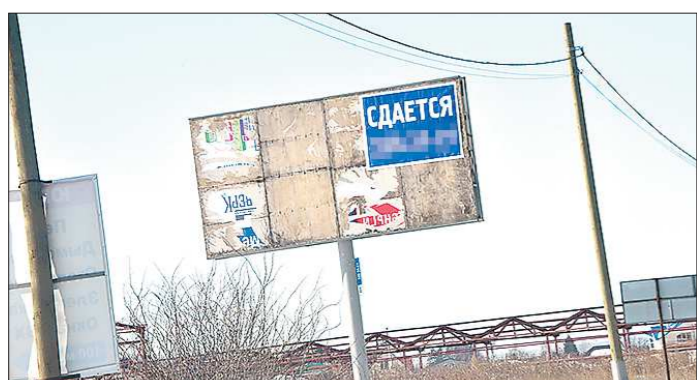
В этом году основная волна демонтажа незаконных рекламных конструкций в Екатеринбурге пришлась на время перед чемпионатом мира по футболу
