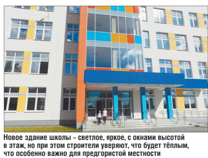
Новое здание школы - светлое, яркое, с окнами высотой в этаж, но при этом строители уверяют, что будет тёплым, что особенно важно для предгористой местности
