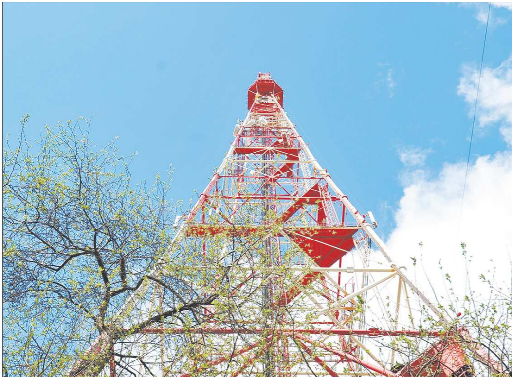
Когда будет построена новая телевышка, эта приёмно-передающая станция на улице Луначарского станет резервной. Кстати, проект новой башни (на схеме справа) был разработан специально для Екатеринбурга
