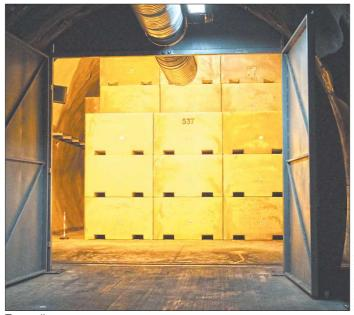
Первый отсек хранилища уже заполнен радиоактивными отходами, скоро его зальют бетоном
