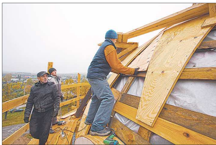
Сейчас на куполе храма идут кровельные работы
