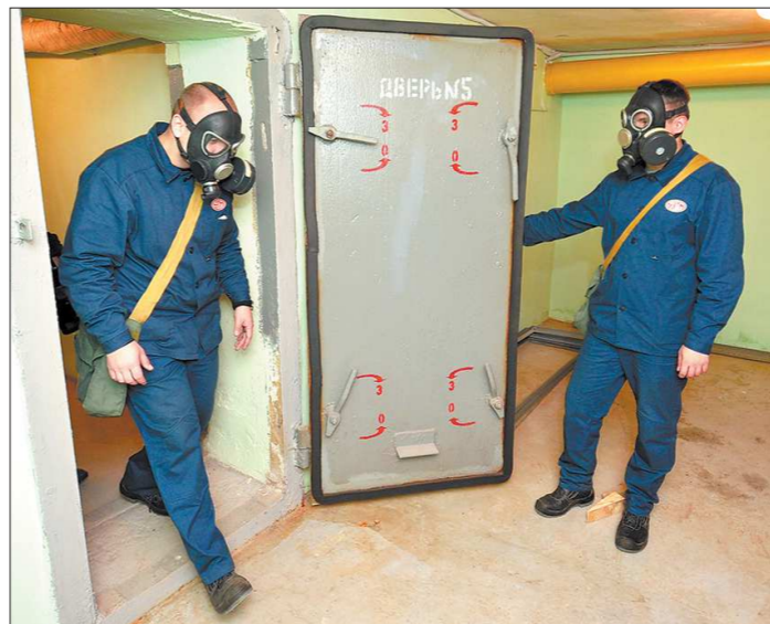
Толстые стальные двери закрываются герметично не только вход-выход, но и отсеки друг от друга
