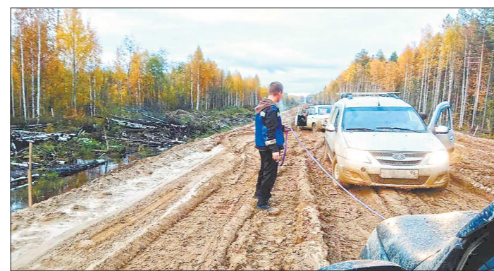
После того, как по глине проезжают большегрузные машины, на дороге остаются огромные колеи. Легковые авто цепляются днищем и баггерями, а кто-то и вовсе застревает — их приходится вытаскивать с помощью тракторов
