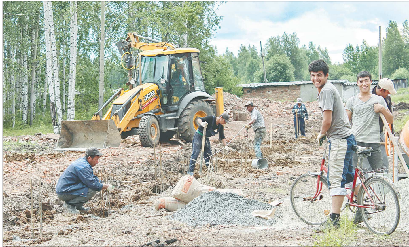
Всё лето в Комсомольском парке кипят работы. К концу 2018 года он должен быть полностью благоустроен
