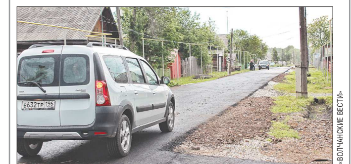
Частный сектор в Волчанске – довольно большой по территории, и людям должно быть комфортно добираться до дома, поэтому здесь дороги асфальтируют
