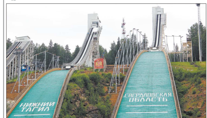
В Нижнем Тагиле на комплексе трамплинов «Аист» продолжается возведение ветрозатиски — специальной сети, которая позволит летанцам лыжникам соревноваться даже при очень сильном ветре. Её отсутствие стало причиной отмены этапа Кубка мира по прыжкам на лыжах с трамплина среди мужчин в прошлом зимнем сезоне.
