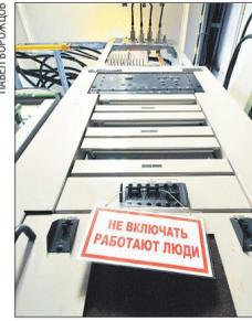
Все регламентные и профилактические работы проводятся только при выключенной аппаратуре
