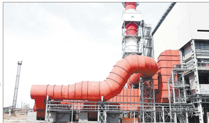
На площадке УАЗа сейчас осуществляется ещё один масштабный проект — строительство газоочистных установок
