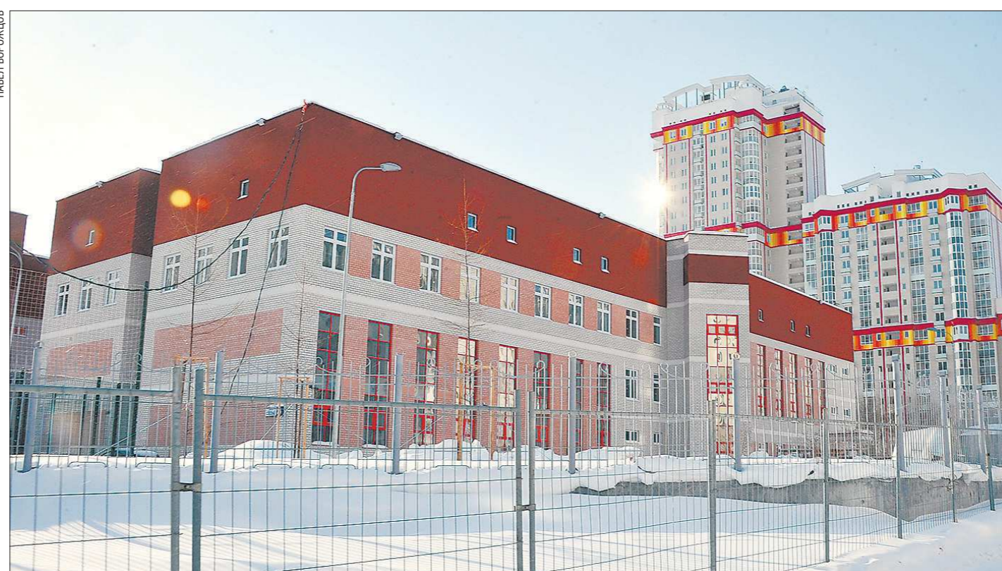
Новое здание гимназии №39 в Чкаловском районе Екатеринбурга сейчас достраивается. Его должны запустить уже в этом году
