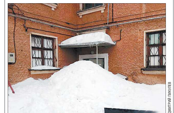
Жители одного из подъездов в доме по Карла Либкнехта, 67 в Ревде уже несколько дней с трудом попадают домой и выходят на улицу из-за огромного снежного вала, пишет портал revda-info.ru . По словам местных жителей, сейчас в доме идёт капремонт, и рабочие сбросили снег с крыши, чтобы отремонтировать кровлю. Люди неоднократно жаловались на снежный вал в свою управляющую компанию, но безуспешно. Коммунальщики за это время так и не смогли договориться, кому убирать снег. Пока же, чтобы выйти из подъезда и зайти обратно, жильцы протоптали тропинки
