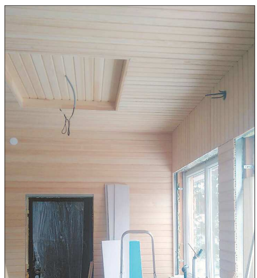
Веранда в процессе обшивки вагонкой без сучка и задоринки
