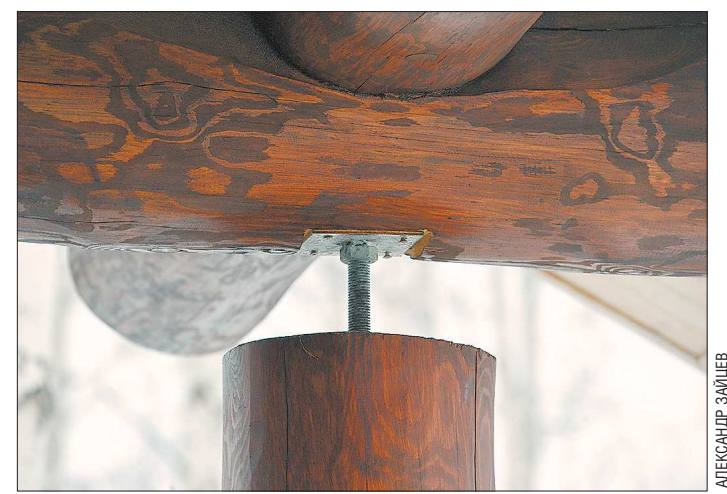
При помощи гайки высота компенсатора меняется
