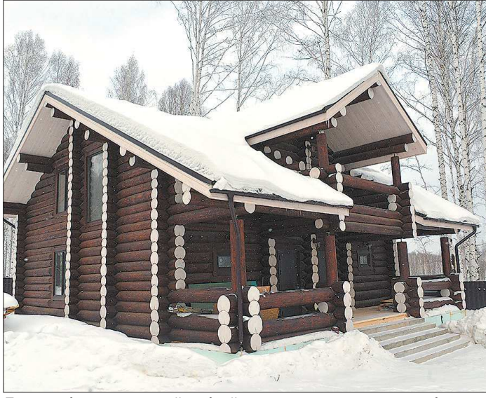
Дом срублен канадской рубкой, на изготовление его сруба плотники потратили четыре месяца
