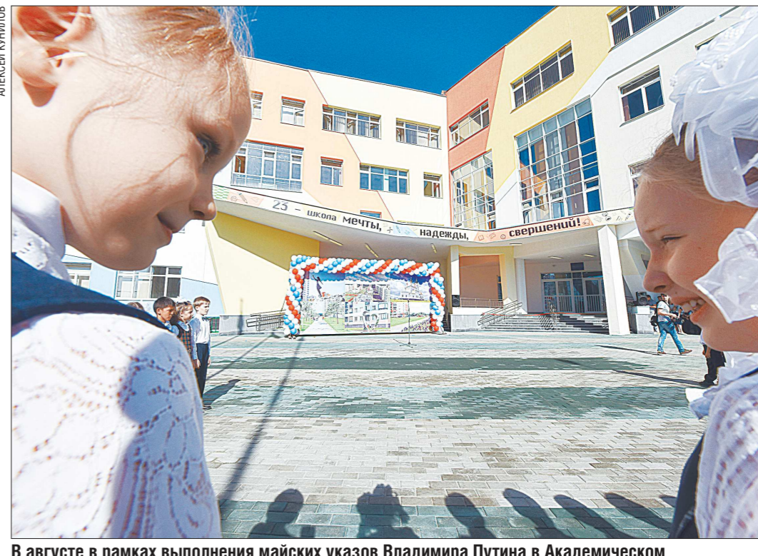
В августе в рамках выполнения майских указов Владимира Путина в Академическом районе Екатеринбурга открылась первая очередь школы № 23. Это первый объект в рамках федеральной целевой программы по строительству новых школ и одно из самых больших и современных общеобразовательных учреждений в России. Школа приняла первую тысячу учеников, ещё 875 примет вторая очередь школы, которая сейчас строится
