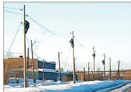
Энергетики монтируют резервную линию
