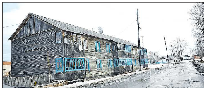
В посёлке Восточном Сосьвинского ГО много старых деревянных домов, где нет централизованного отопления
