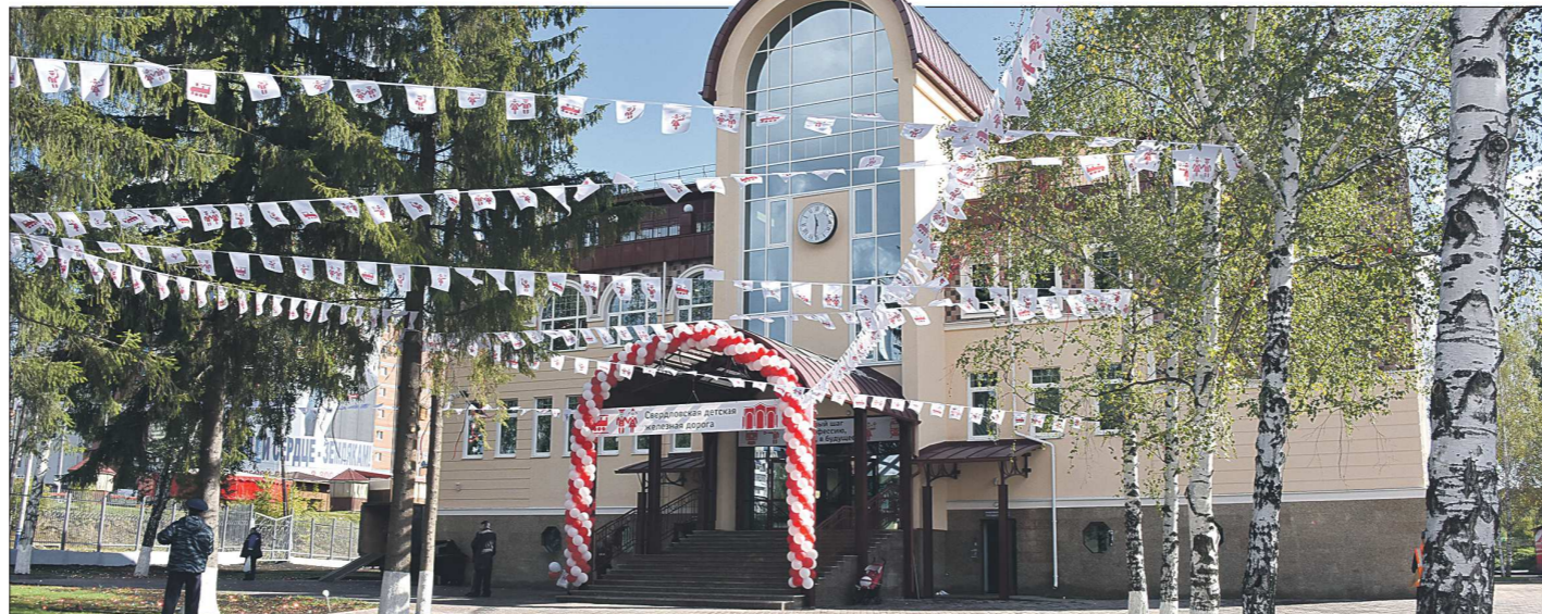
Новый комплекс зданий и сооружений Детской железной дороги включает в себя четырёхэтажное здание вокзально-проформентационного комплекса, эстакаду, локомотивно-вагонное депо, путевое хозяйство и другие объекты. Общая стоимость проекта составила 735,4 миллиона рублей
