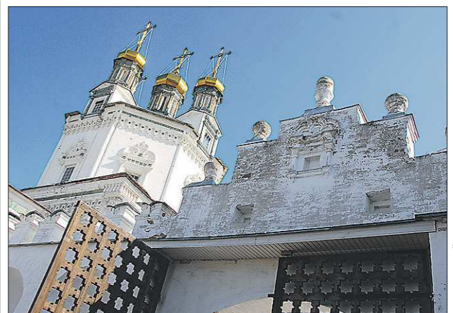
Каждая створка двух пар ворот Верхотурского кремля весит 640 килограммов и состоит более чем из 200 деталей
