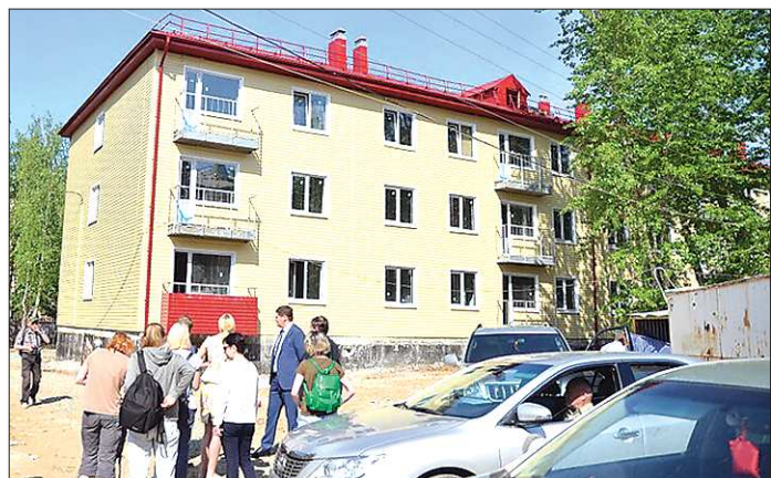
На встречу с жителями свердловский премьер приехал сразу после осмотра строящегося дома для переселенцев из аварийного жилья, по которому у краснотуринцев тоже были вопросы. Месяц назад нерадивого подрядчика сменили. У новых строителей остался месяц, чтобы сдать объект
