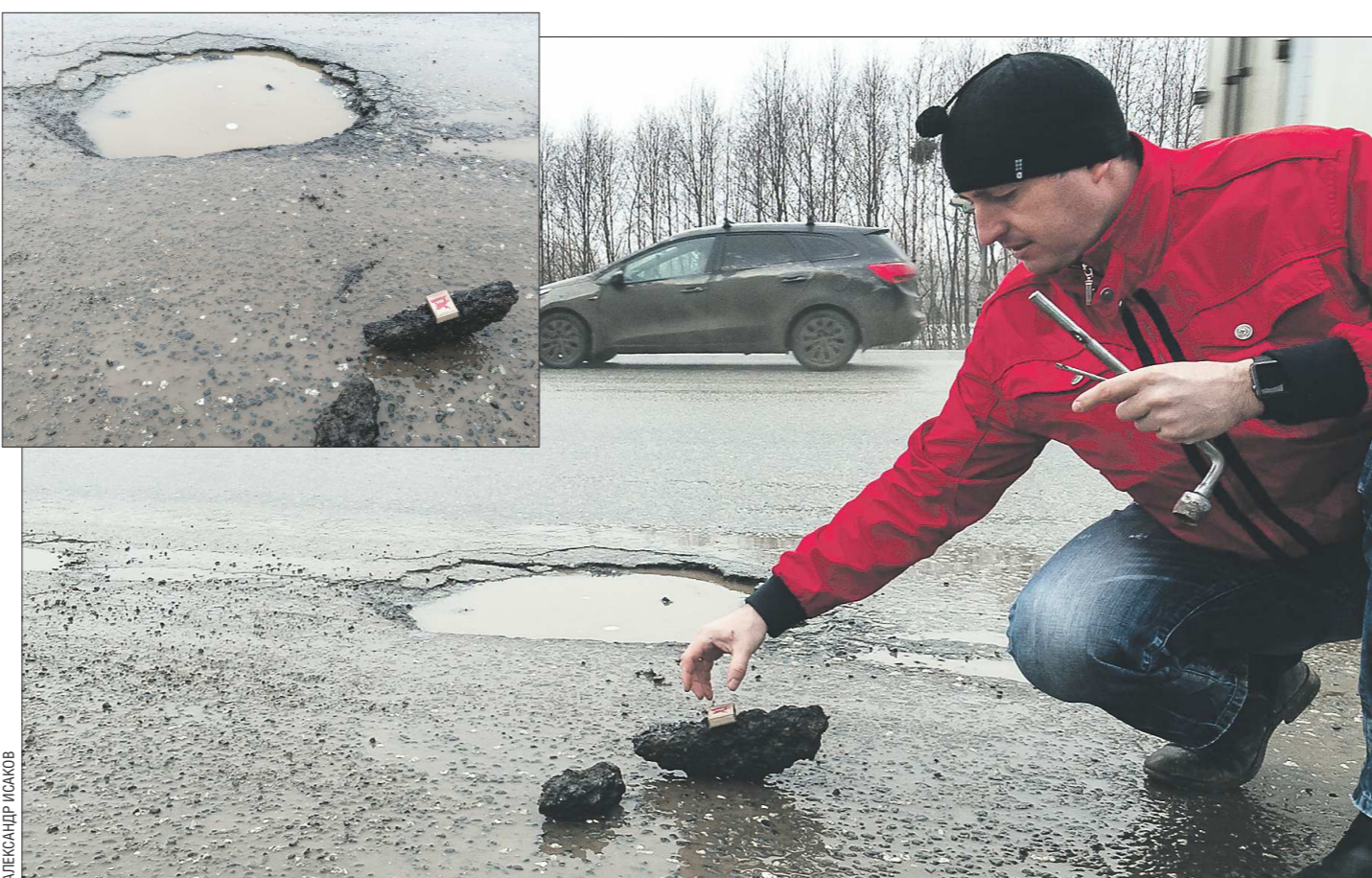
Алексей Беззуб показывает, что толщина асфальтового покрытия — 4,5 сантиметра вместо положенных десяти
