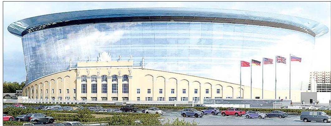
Возведение пилонов завершится к концу 2016 года
