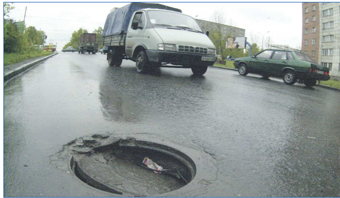
МУП «Водоканал» в Екатеринбурге осматривает люки по графику — раз в месяц
