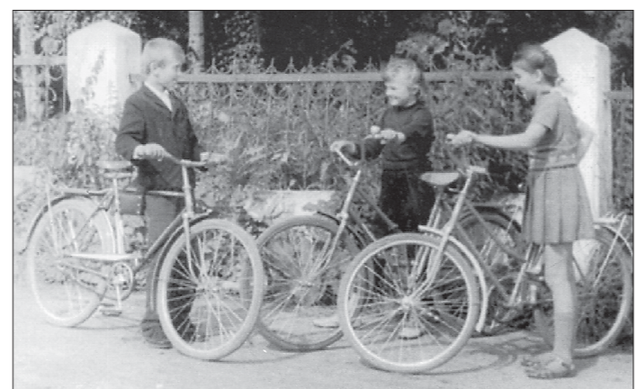
«Уралец» (на фото — слева) и «Рябинка» — это как брат и сестра. Первый предназначался для мальчиков и имел горизонтальную (закрытую) раму. «Рябинка» была девчачьим велосипедом с наклонной (открытой) рамой
