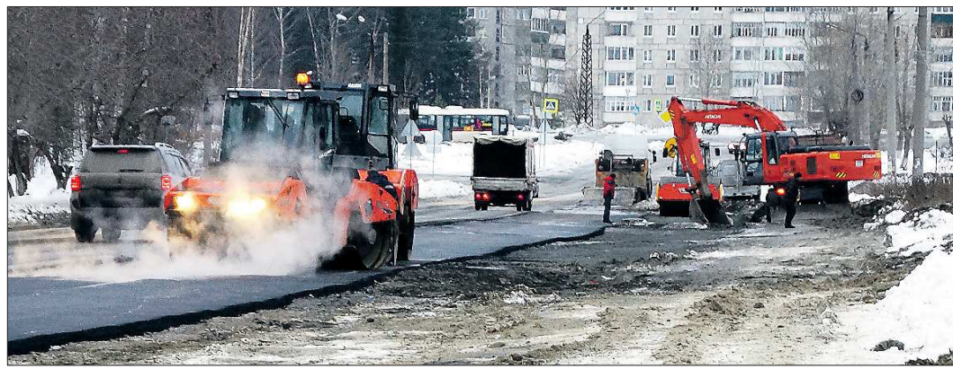
В Качканаре асфальт на улице Свердлова начали укладывать только в октябре — прямо на снежную «кашу»
