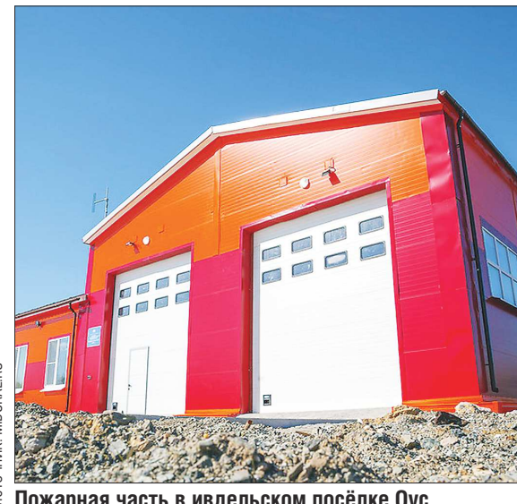
Пожарная часть в ивдельском поселке Оус переехала в новое здание из деревянного барака с 90-процентным износом
