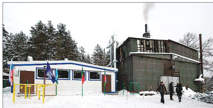
Новая котельная вывела Первоуральск на финишную прямую по газификации территории
