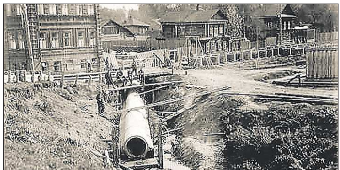
Первые водоводы на Урале начали прокладывать в начале XX века. Как показало время, работа сделана на совесть
