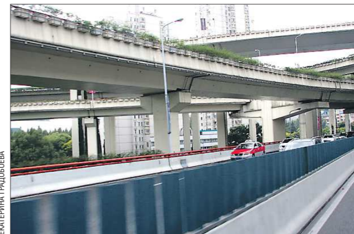
К строительству многоуровневых шоссе и развязок в Шанхае приступили с начала 90-х. Сегодня эта работа в центральной части города сделана, на очереди — городские окраины
