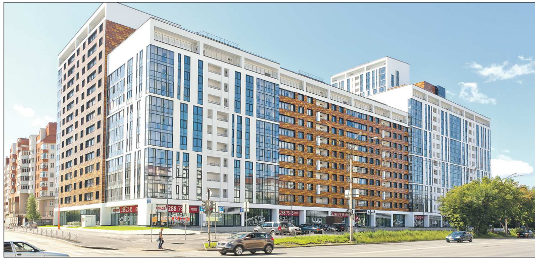
В отделе фасада впервые в городе использованы оригинальные линейные панели (из тонколистовой стали с декоративно-защитным покрытием)
