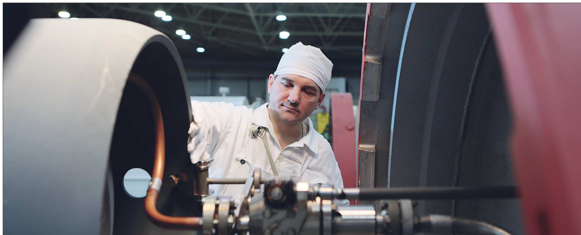
Спецучасток «Челнок» цеха разделительного производства УЭК (на фото инженер-технолог Александр Петров)
