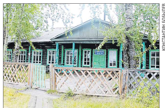
Школа расположена на холме, в самой высокой точке посёлка. Несмотря на то, что здание закрыто на замок, местные жители умудряются беспрепятственно проникать внутрь.
