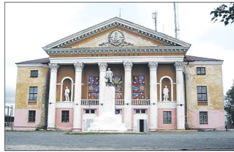
ДК в Левихе перешёл на автономно. Но заработать на ремонт пока так и не смог
