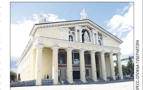
Средства на проведение работ выделялись из федерального и областного бюджетов. Общая стоимость реконструкции составила более 200 миллионов рублей. В рамках реконструкции в театре было заменено кровельное покрытие, утеплены чердачные перекрытия, произведён ремонт системы электроснабжения. Первое мероприятие в обновлённом здании прошло уже вчера — в стенах учреждения культуры состоялось торжественное собрание, посвящённое празднованию Дня города Нижний Тагил.
