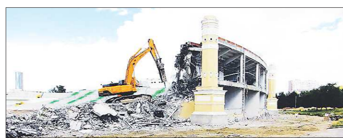
Работы по демонтажу арены уже идут, а завершить реконструкцию планируют в декабре 2017 года
