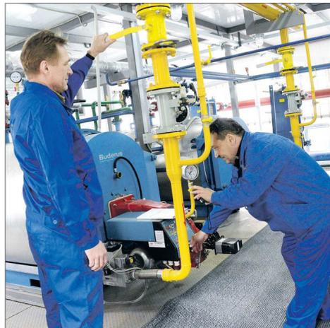
В новой котельной, построенной в Нижних Сергах в рамках пилотного проекта, идут пусконаладочные работы, которые завершатся к началу отопительного сезона
