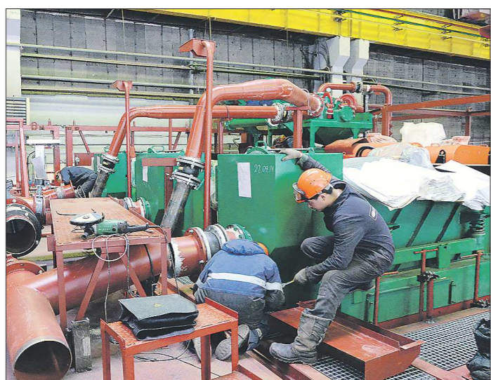
Монтаж циркуляционной системы, предназначенной для нефтяников, почти закончен. Работа в одном из цехов УЗТМ идёт в две смены. Успеть нужно точно в срок
