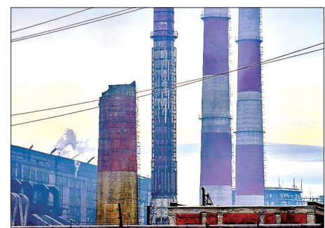
Обрушение трубы не повлияло на работу Богословской ТЭЦ
