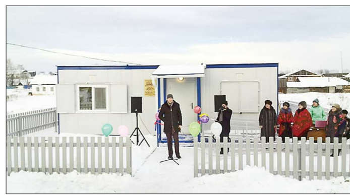
ФАП в Ключиках — первый в округе, который построен по быстровозводимой модульной технологии
