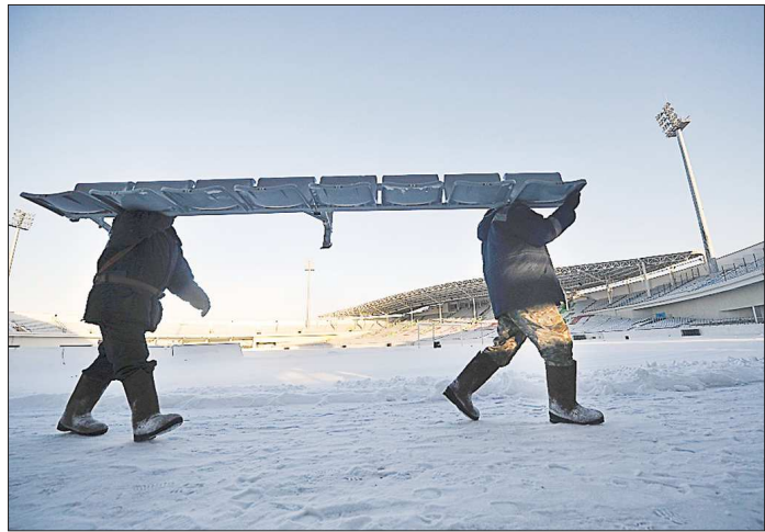
Две тысячи позиций инвентаря демонтированного оборудования получат в пользование муниципалитеты для установки на своих спортивных сооружениях
