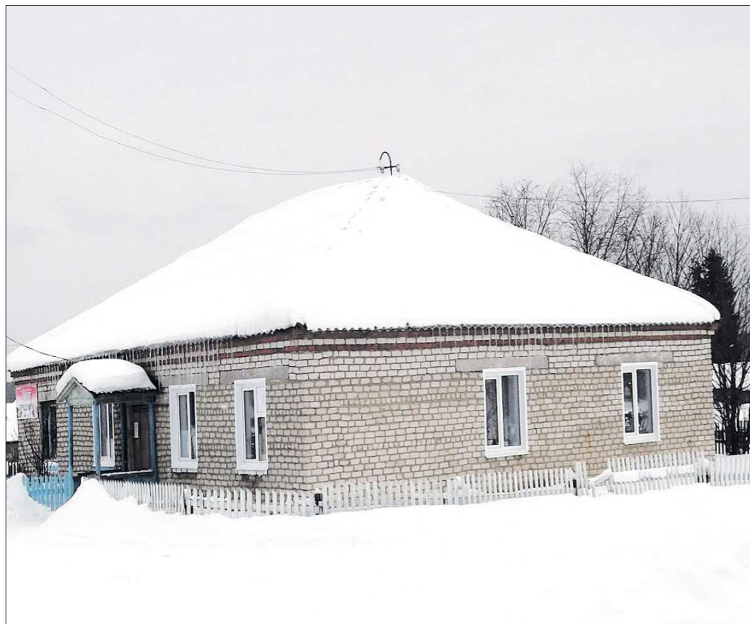
Для небольшого села ФАП в Лебёдкино довольно хороший — пусть не новый, зато после капитального ремонта
