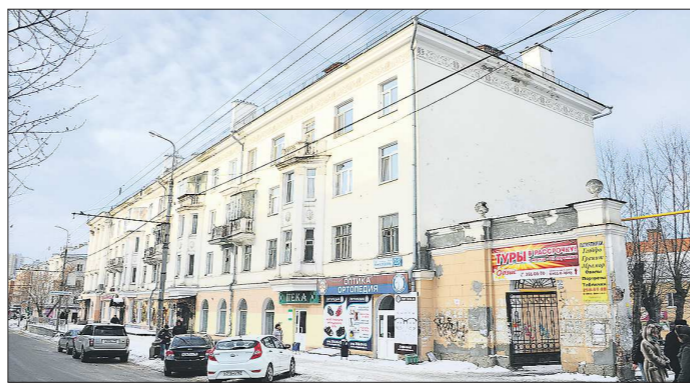
Нынешние обитатели этого дома наверняка и не догадываются, кто жил в последнем подъезде в квартире № 51. Хозяйка квартиры дверь нам открыла... тут же закрыла. Можно понять...
