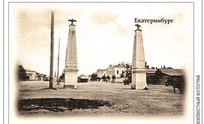
Столбы царского времени были кирпичными и намного выше, чем современные
