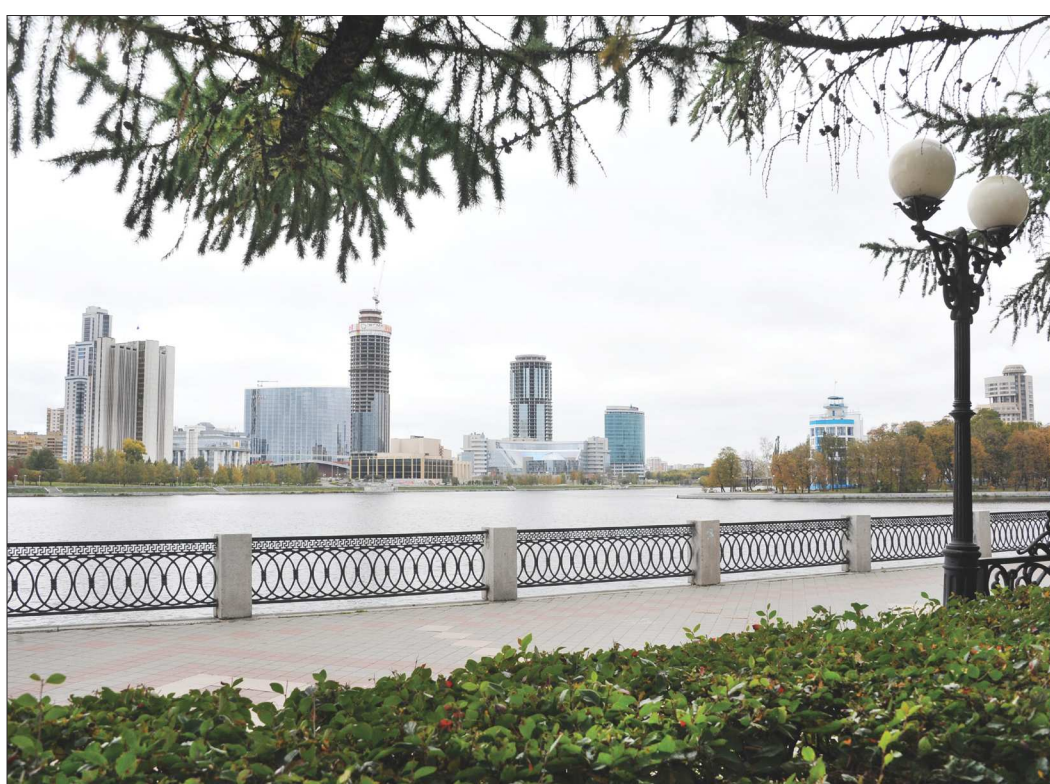
По числу высотных зданий Екатеринбург вышел на первое место среди региональных городов-миллионников. Одна из причин – дефицит свободной земли и чрезвычайно высокая цена на неё
