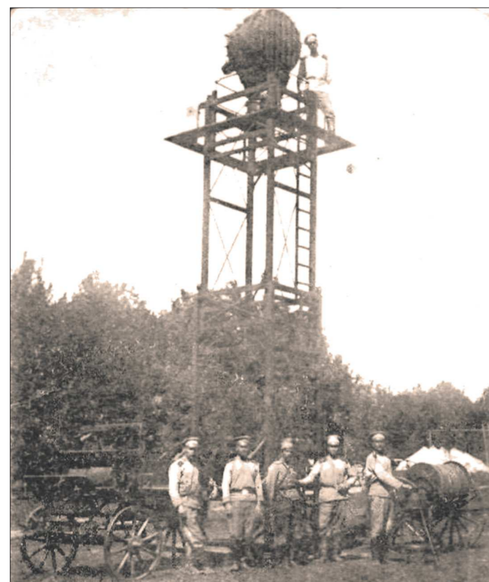
Изобретение Первой мировой – не только танки, пулемёты и отравляющие газы, но и прожектора. Вышка полевого прожектора
