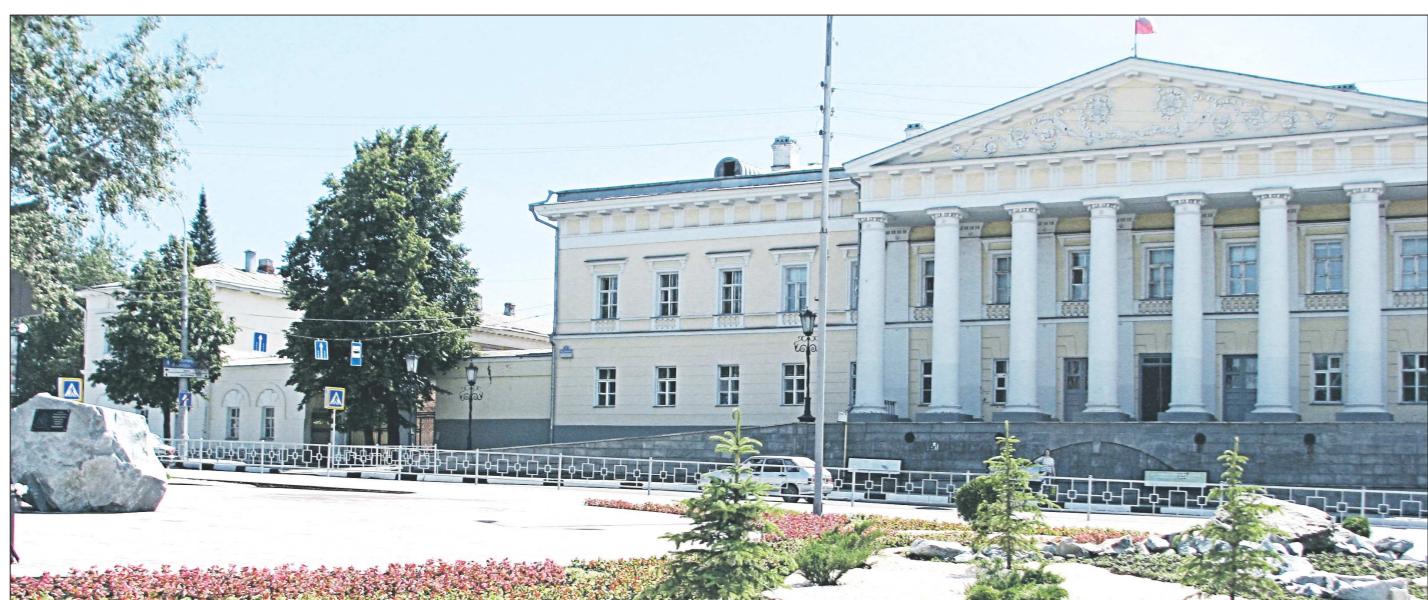
Ещё месяц назад на площади вовсю работала строительная техника. Уже сегодня здесь аккуратно уложена плитка и высажены растения
