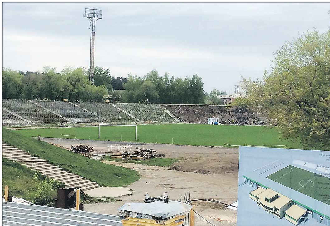
На стадионе уже завершён демонтаж административного здания, начаты работы по разборке и демонтажу трибун и футбольного ядра
