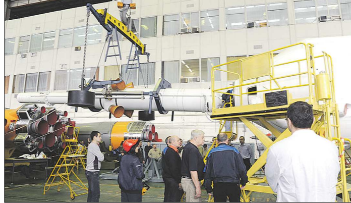
Монтаж системы аварийного спасения
