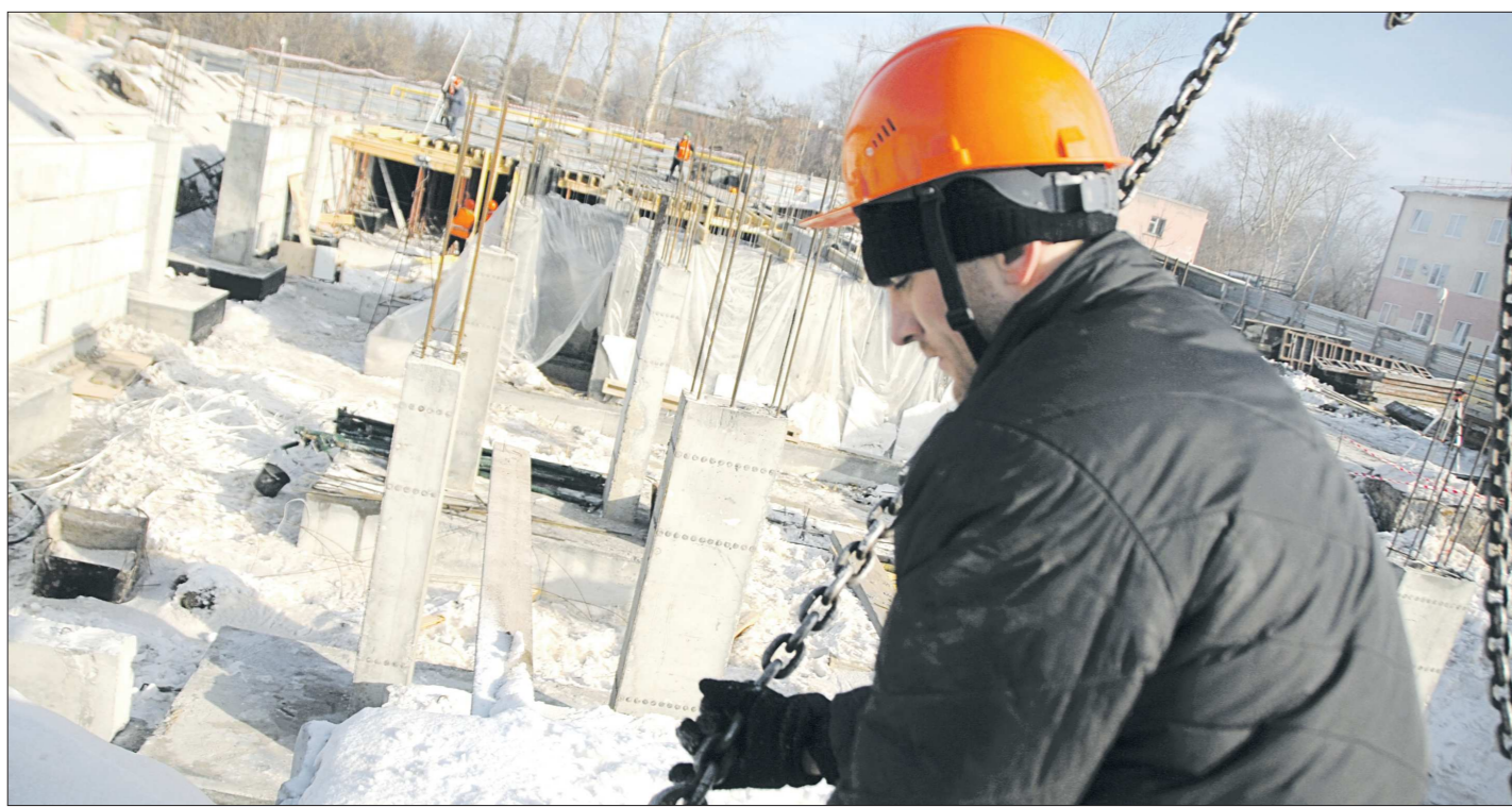
Строители обещают к середине мая завершить возведение монолитных конструкций
