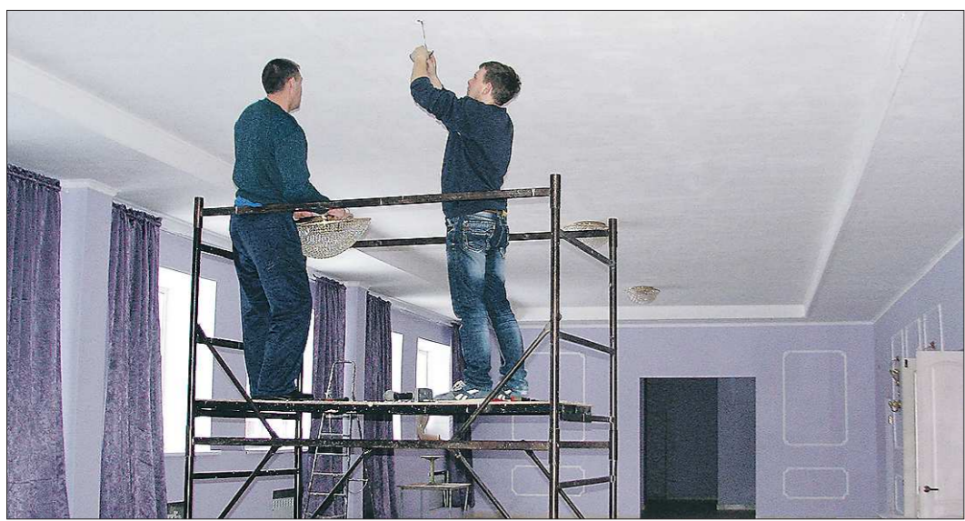
В нижнесалдинском Доме культуры идёт ремонт, на который местная казна не тратит ни копейки
